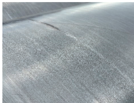
Stopień oczyszczenia S03
